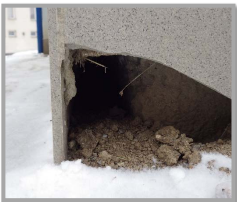
Obrázek č.2: (chybějící svislá hydroizolace soklové části)
