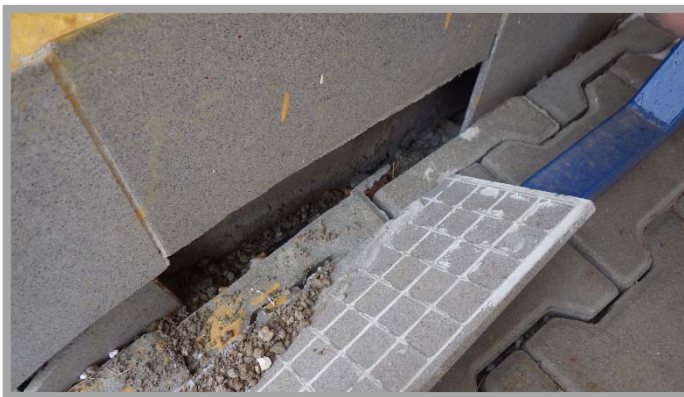
Obrázek č.2: (chybějící svislá hydroizolace soklové části)
