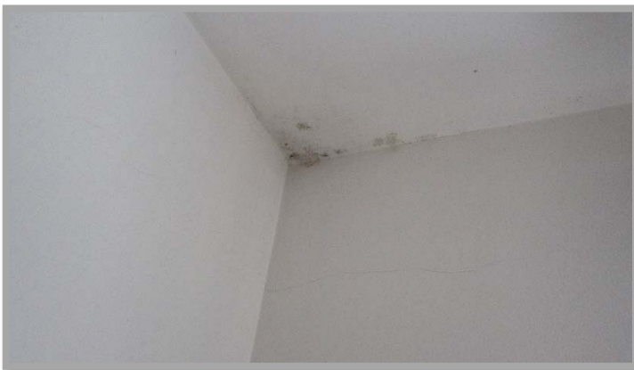
Obrázek č.6,7: (Plíseň na ztužujícím věnci a prahu balkonových dveří)
