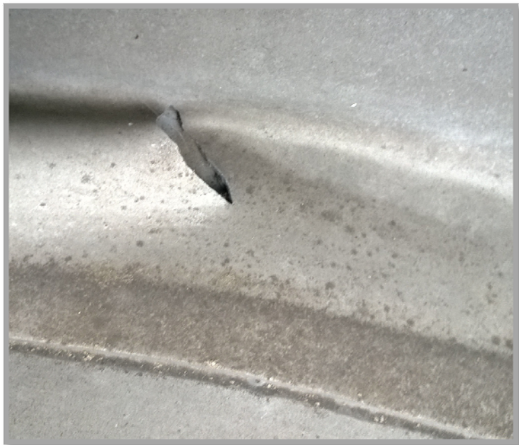
Obrázek č.9,10: (mechanické poškození folie )
