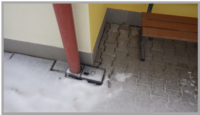
Obrázek č.2: (Pokles konstrukce okapového chodníku)
