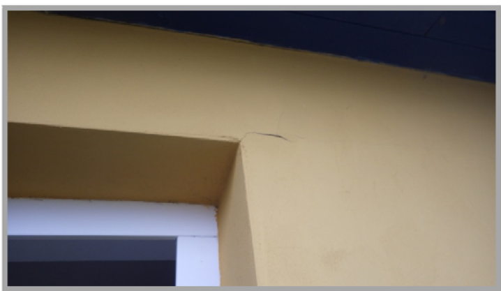
Obrázek č.4: (Otevřená spára okno stěna)
