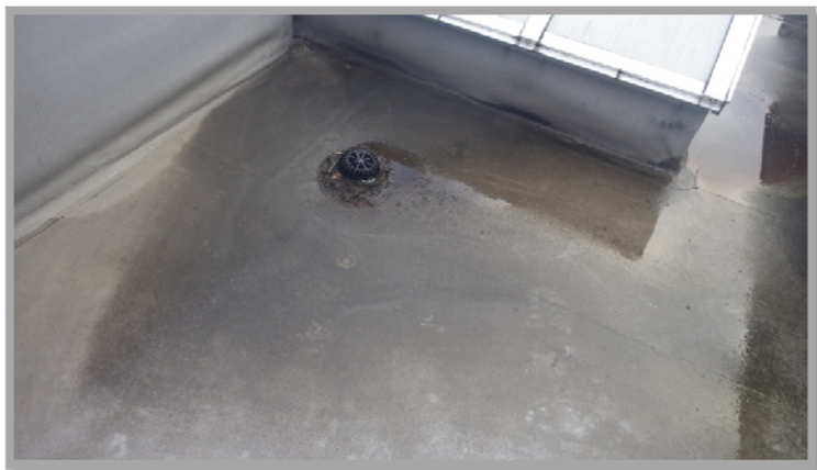
Obrázek č.10: (Ucpaný krycí košíček vpusti)
