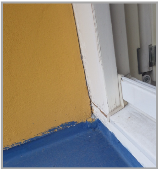
Obrázek č.4: (Otevřená spára okno stěna)
