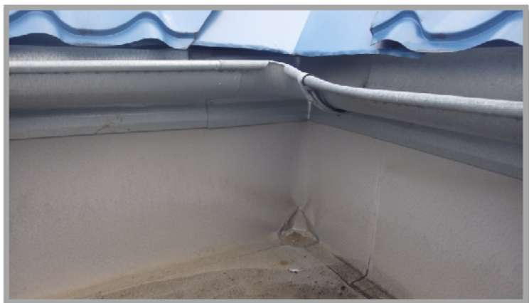
Obrázek č.12: (Střešní žlab)
