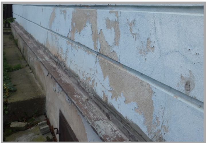
Obrázek č.4: (Tmelení oplechování soklového zdiva)
