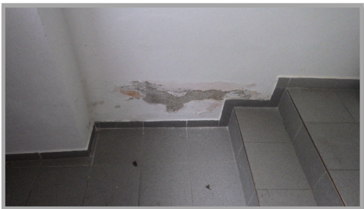
Obrázek č.7: (Sanitr na vnitřní stěně v 1.NP)
