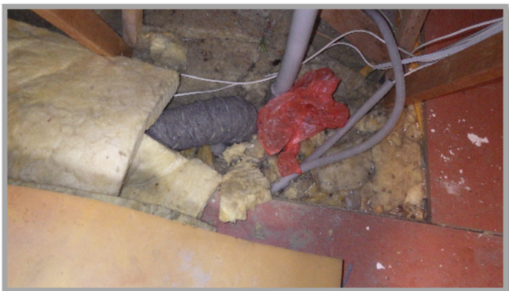
Obrázek č.8: (Instalace v tepelné izolaci)
