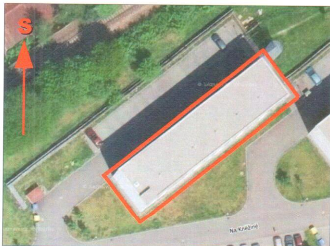
obr. /1/ Letecký pohled (zdroj: http://www.mapy.cz/ ) s vyznačením předmětného objektu (červené ohraničení) a s orientací ke světovým stranám
